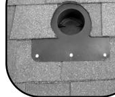
3. Deux options sont possibles, brancher maintenant le conduit de l'aérateur sur l'adaptateur en utilisant un collier de serrage ou, après l'installation, brancher le conduit, de l'intérieur des combles.
